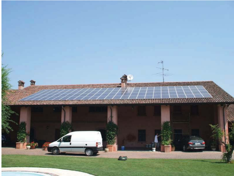
Figura 7 – Esempio di installazione idonea alla classificazione dell’impianto fotovoltaico nella categoria “su edifici” in caso di installazione complanare su un tetto a falda
